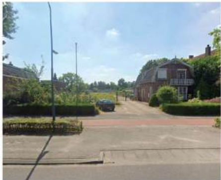
Huidige situatie: zicht op het plangebied vanaf de Tilburgseweg gezien
