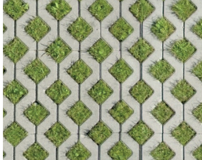
Opstelplaatsen calamiteiten, grasbeton
