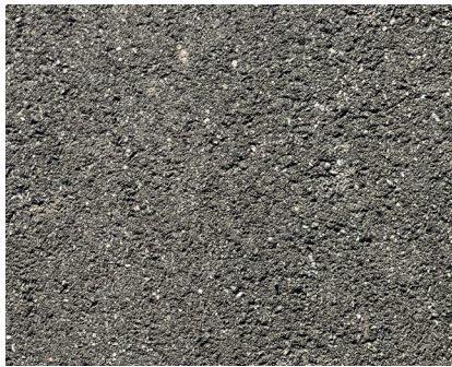
LV route en rijbaan, grijs asfalt met slijtlaag
