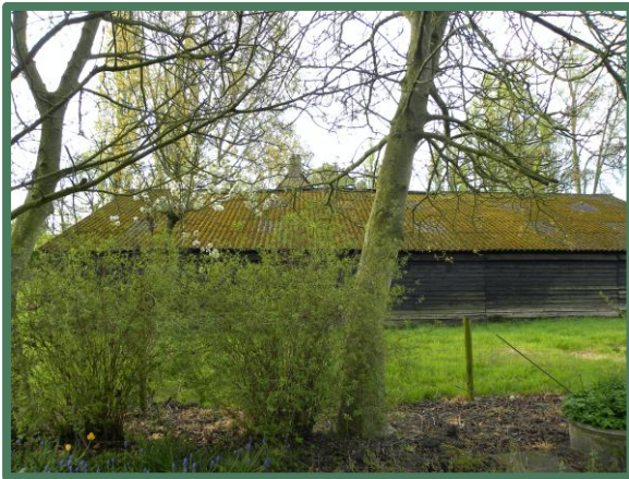
Foto 3: Overzicht schuur vanaf het noorden.
