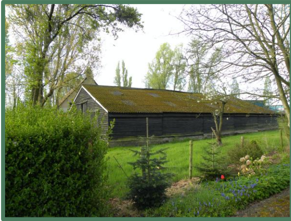
Foto 1: Overzicht schuur vanaf het noorden.
