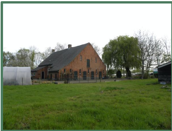
Foto 11: Overzicht woning, vanaf het zuiden.
