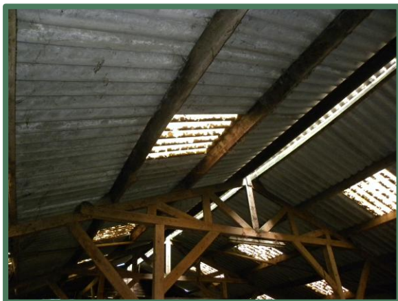
Foto 21: Overzicht op het dak.
