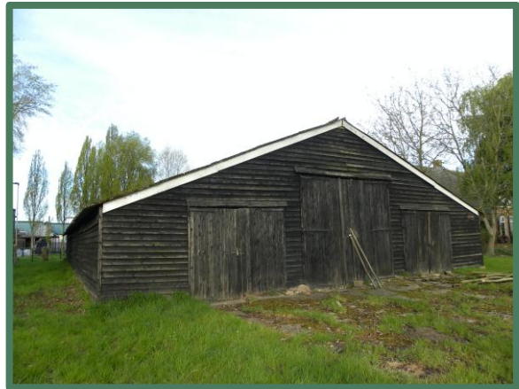
Foto 10: Overzicht kopgevel, vanaf het oosten.
