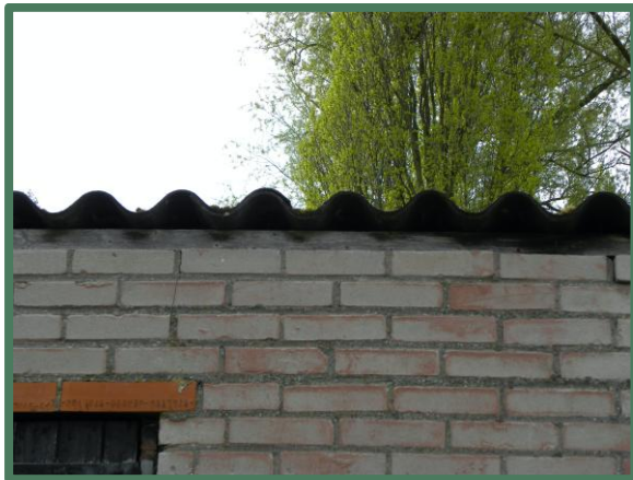
Foto 19: Muurplaat op de wand.
