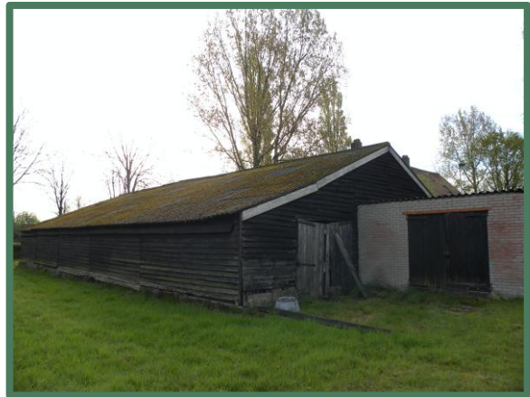
Foto 4: Westelijke kopgevel, vanaf het noordwesten.
