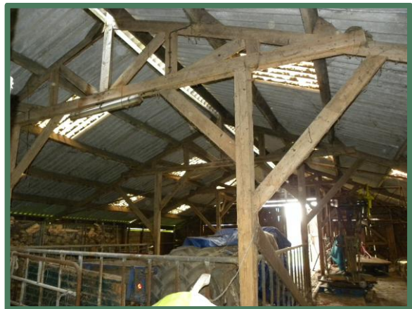
Foto 6: Overzicht op het dak, vanaf de binnenzijde.
