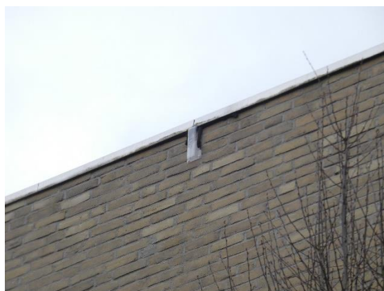
Foto 5: exclusion flap, zal nagelopen moeten worden om de functie ervan te controleren.
