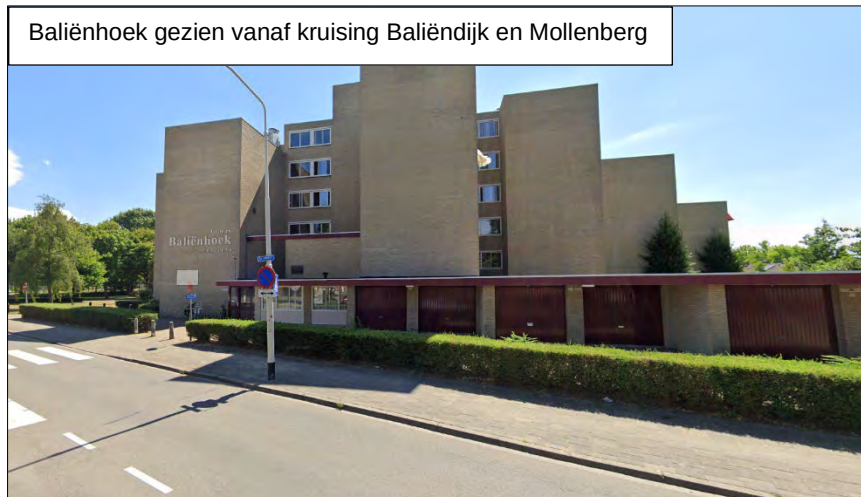
Figuur 3: Digitaal beeldmateriaal terreinverkenning.
