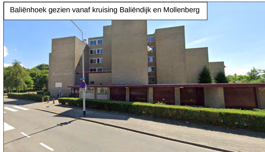
Figuur 3: Digitaal beeldmateriaal terreinverkenning.
