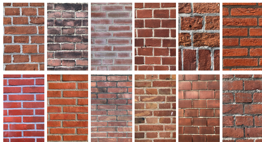
Metselwerk bestaande gebouwen in Tuinzigt en aan de Tramsingel
