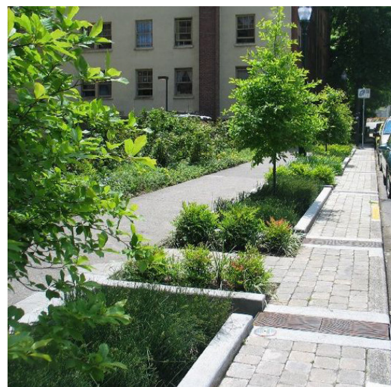
Band/lage keerwand om lager gelegen beplanting en betonnen brug over laagte
