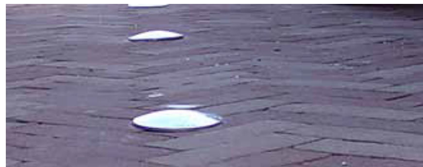
Subtiel markering in trottoir bij inrit parkeergarage
