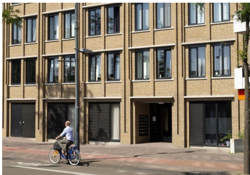
Gevel van fietsenstalling is transparant en sluit aan bij gevel woningen
