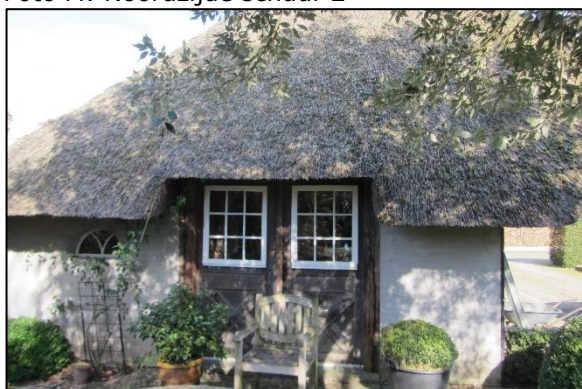
Foto O: Zuidzijde schuur 2
