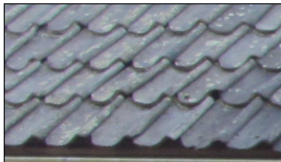
Foto B: Ingezoomd beeld op dakpannen
