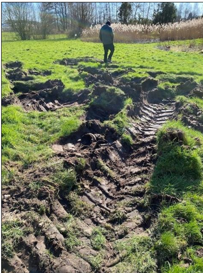
Afbeelding 7: Zicht op het terrein achter het huis waar de kraan in februari 2023 diep wegzakte in de drassige bodem.
