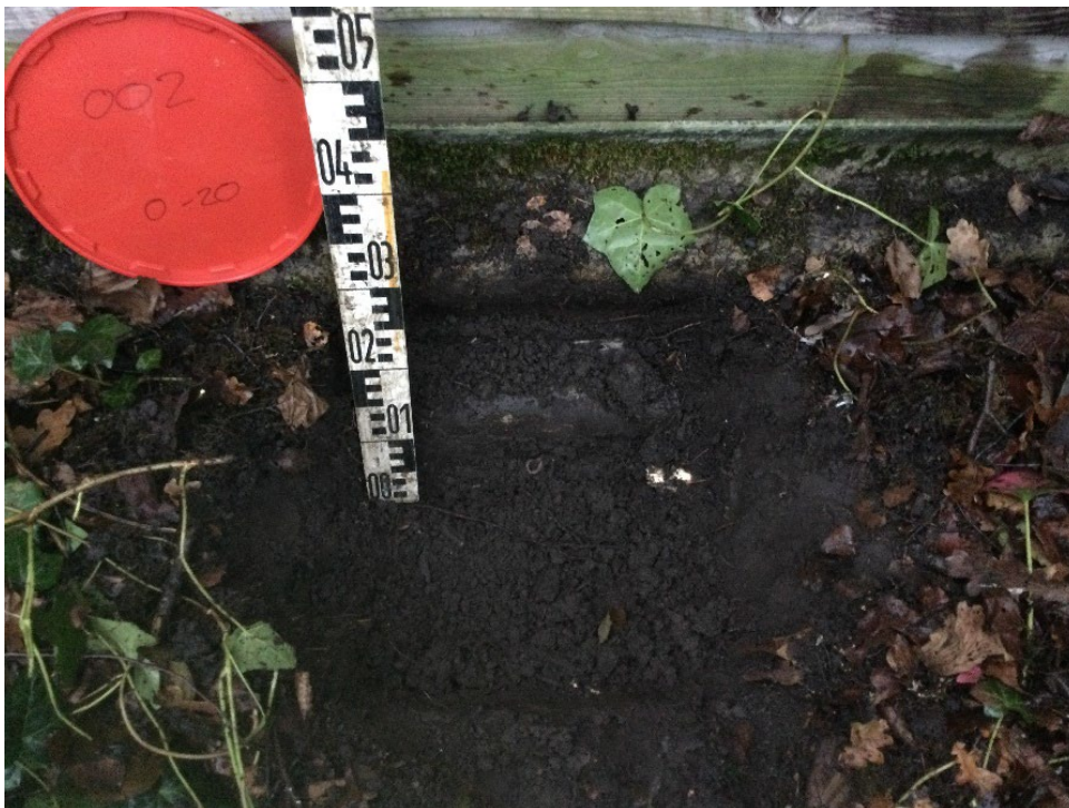
Figuur 1.3: Foto van proefgat 002 ter plaatse van de druppellijn. Hierop is de aangetroffen asbestgolfplaat langs de funderingslijn te zien.
