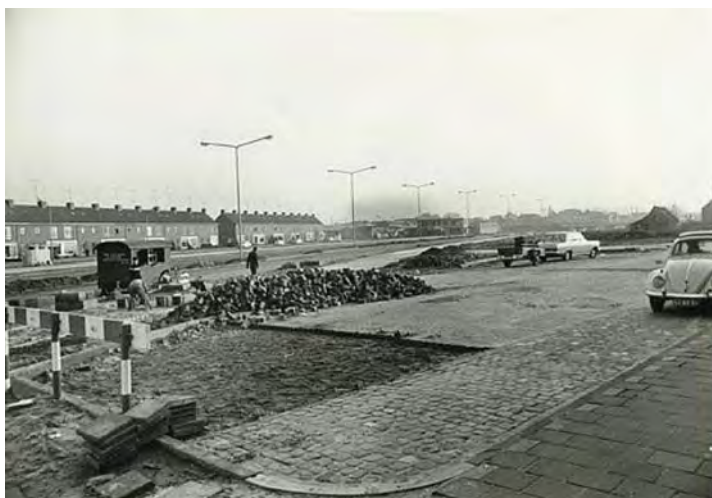
Figuur 49. Aanleg Doornboslaan
