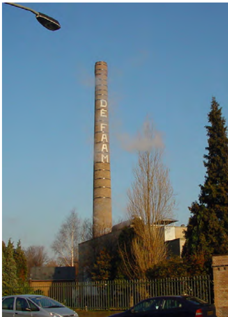
Figuur 18. Bestaande schoorsteen De Faam
