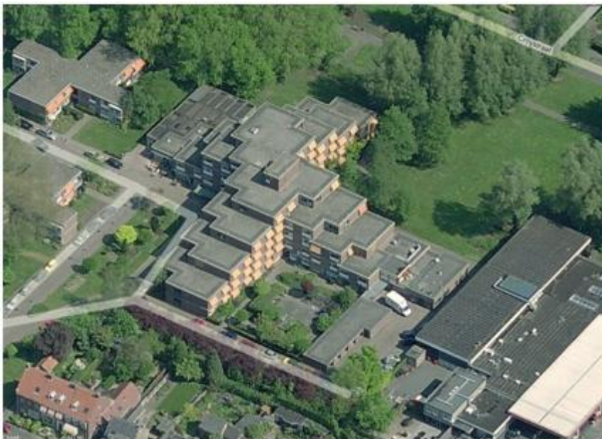
Figuur 2: het hoofdgebouw
