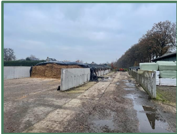
Overzicht verharding en sleufsilo's
