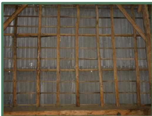
Binnenzijde dak van de Vlaamse Schuur
