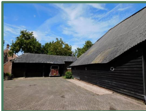
Karschuur vanuit het oosten
