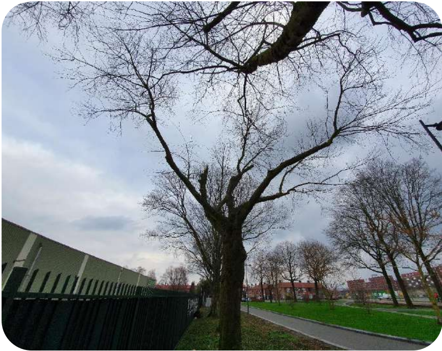
Foto 3: takstompen resterend na takbreuk in boomnr. 6
