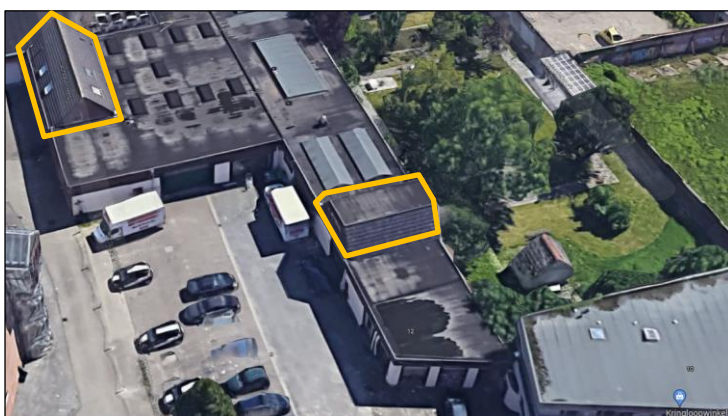
Figuur 9. De daken met dakpannen in het projectgebied (bron: googlemaps.com).
