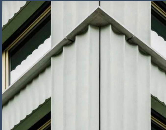
Alzijdig ontwerp met geornamenteerde facade
