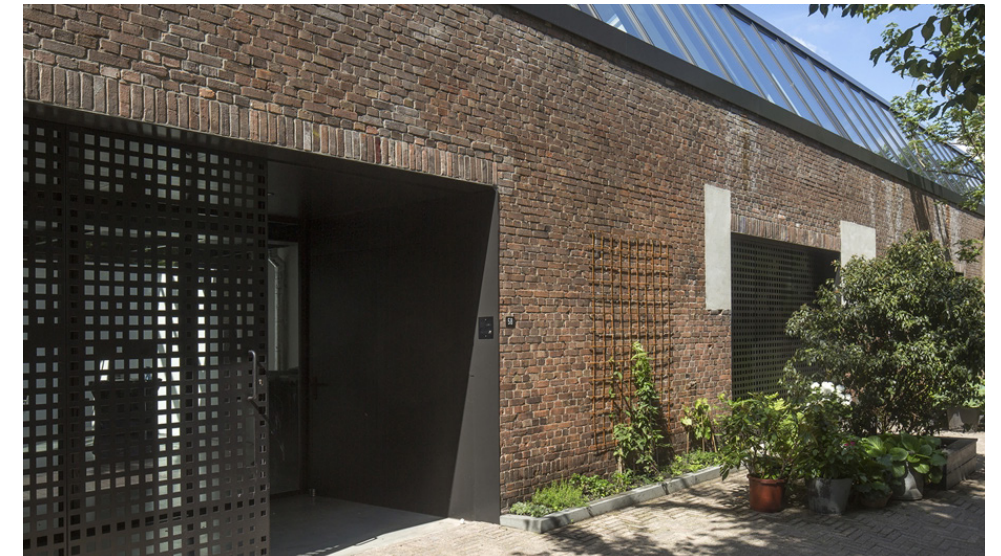
Technisch ruimtes onderdeel van de architectuur
