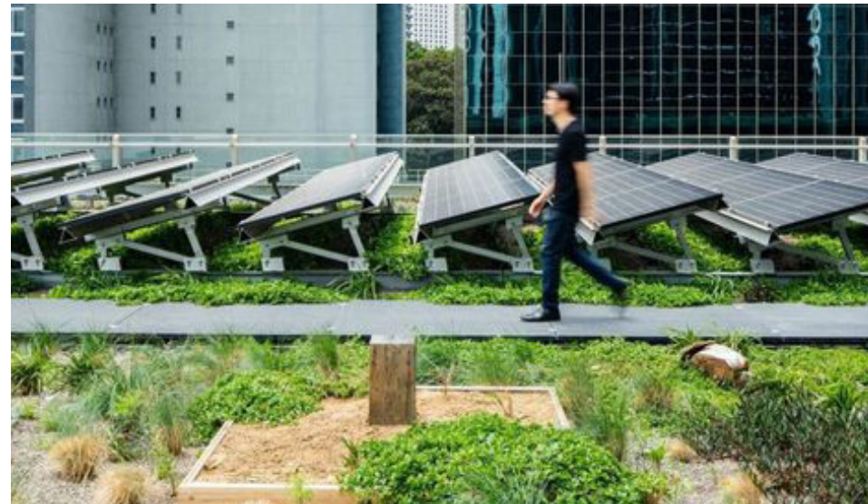
Zonnepanelen niet zichtbaar vanaf maaiveld of vanuit de appartementen
