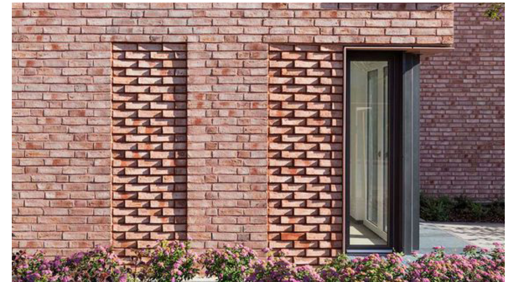
Gevels met rijke detaillering & reliëf
