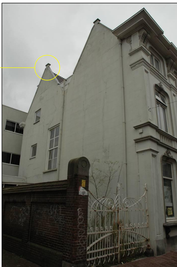
Afbeelding 6: Zijgevel links. De voormalige zakgoot is dichtgezet. Hier bevinden zich in de gevel twee driehoekige venstertjes. Inzet met een van de 17de-eeuwse ankers.
