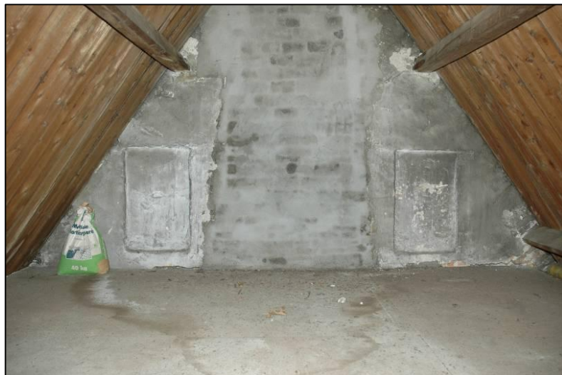
Afbeelding 36: Beide topgevels aan de rechterkant bevatten nissen van dichtgezette vensters, welke aan de buitenzijde niet direct te zien zijn. Op de voorste zolder is een rookkanaal verwijderd.
