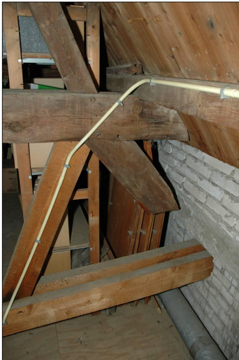
Afbeelding 37: Aan de linkerzijde van de achterste kap is ten behoeve van de lift (zie borstwering!) een spantbeen afgezaagd. Dit is met een nieuwe constructie in vurenhout gecompenseerd.
