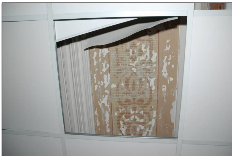
Afbeelding 28 en 29: Op de verdieping is in de vertrekken rechtsvoor een belangrijk deel van de 19de-eeuwse plafonds bewaard. In het tweede vertrek van rechts zien we een plafond waarin gestuct lijstwerk gecombineerd is met een daaromheen lopende sjabloonschildering.
