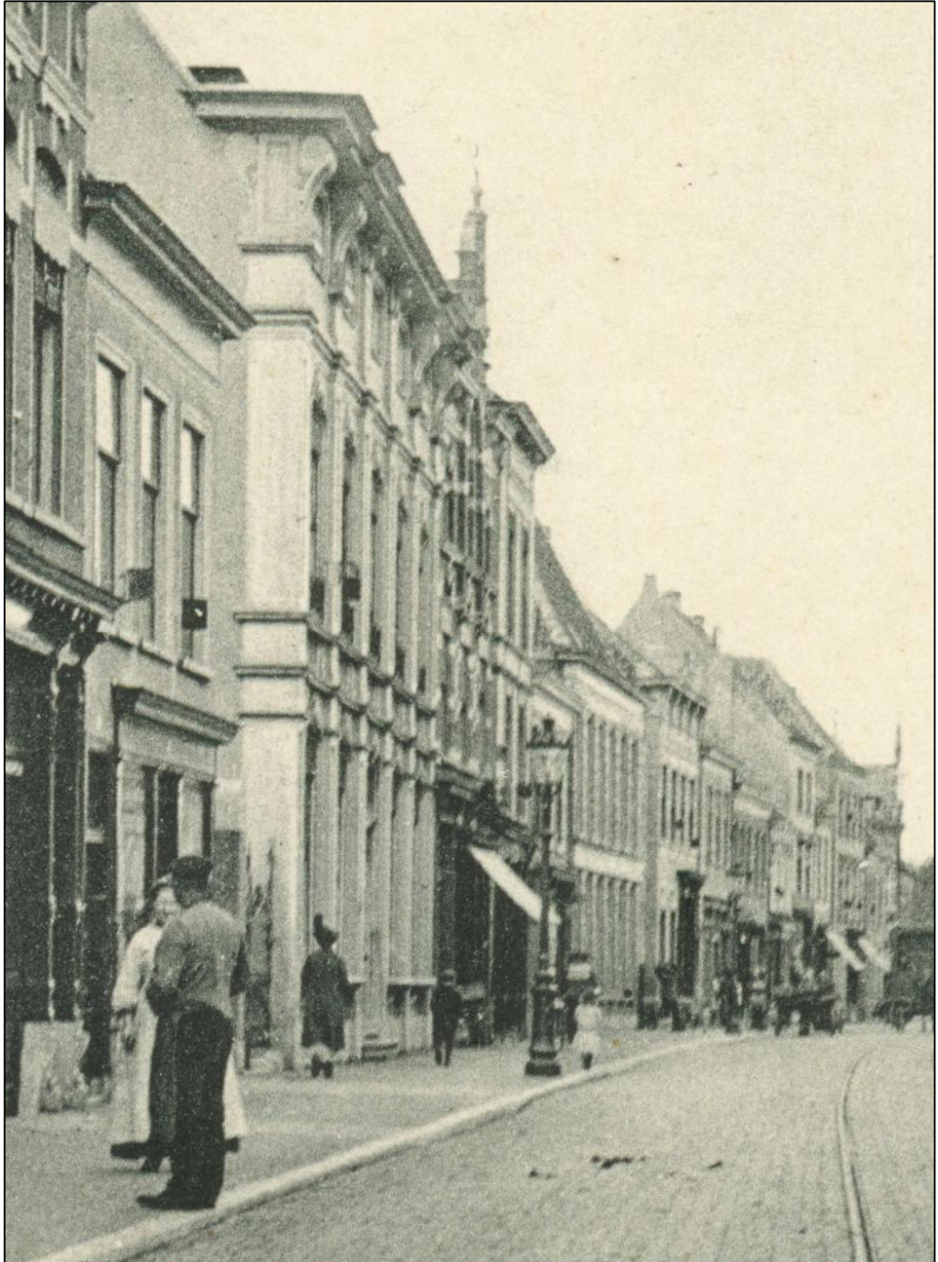
Afbeelding 3: Uitsnede uit een Ansichtkaart uit het begin van de 20ste eeuw. Aangezien het nu nog bestaande hek aanwezig is, moet de foto van na 1903 zijn. [Beeldbank Stadsarchief Breda, A0142]
