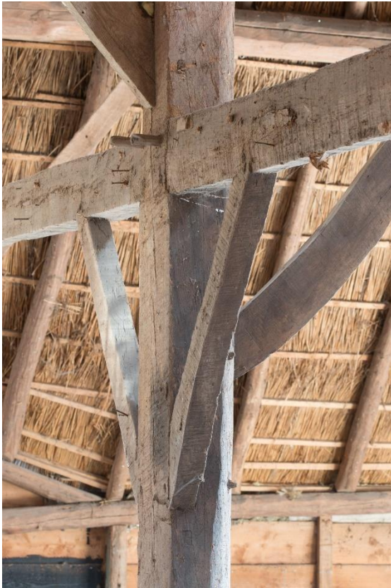
Links is nogmaals te zien hoe de regels en de windverbanden aan de zijde van de karbeuk zijn uitgelijnd. Rechts is een gat te zien, zoals in de voet van iedere stijl aanwezig, vermoedelijk om het stellen van de gebinten te vergemakkelijken.
