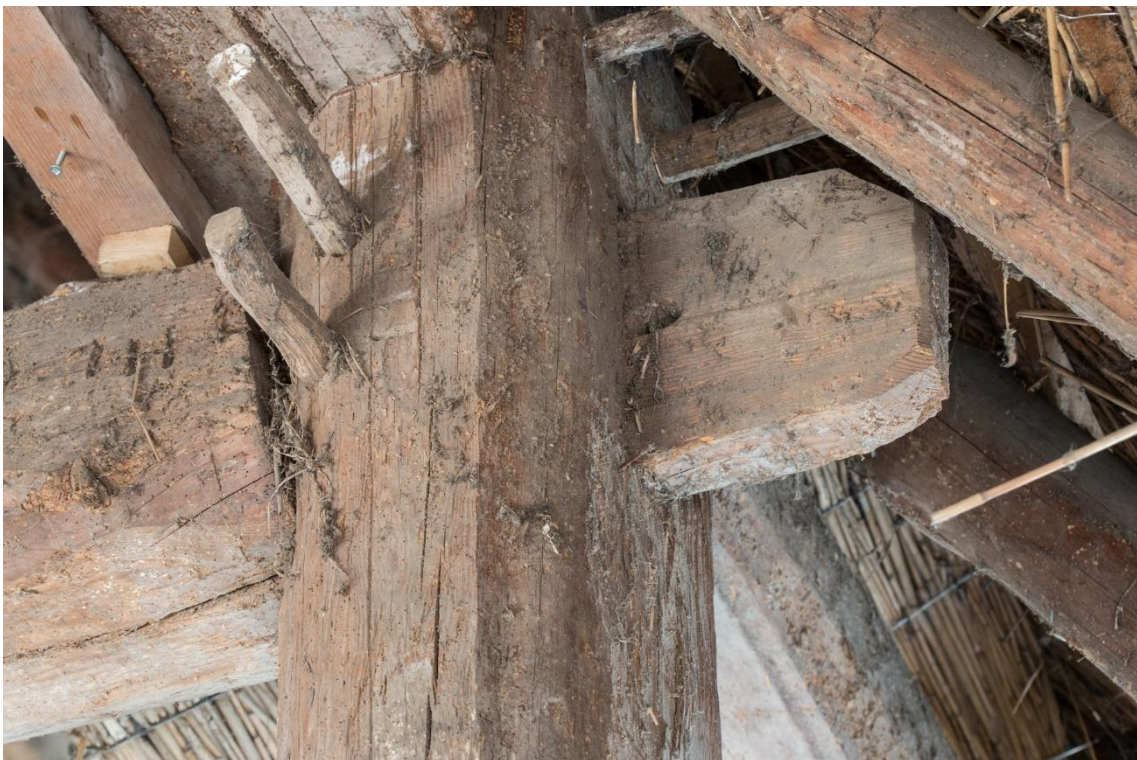
Detail van de ankerbalk van gebint III. Op het hout zijn hart- of waterpaslijnen gekrast.
