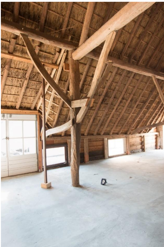
Gebint II is aan de zuidzijde voorzien van gekromde windverbanden.
