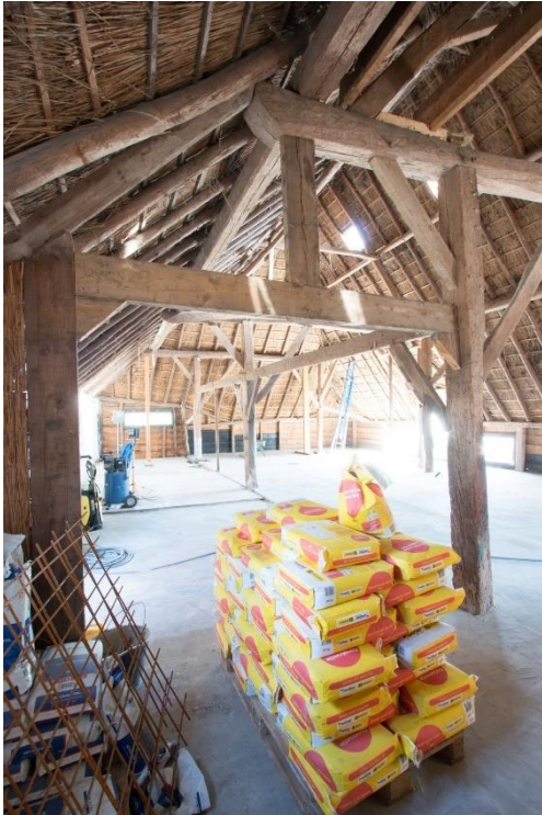
Gebint III met detail van het de secundaire hulpconstructie over het overstek dat rekening houdt met inrijden van een kar. Rechts van onderaf gezien het overstek van de gebintplaat, ten behoeve van de karinrit.
