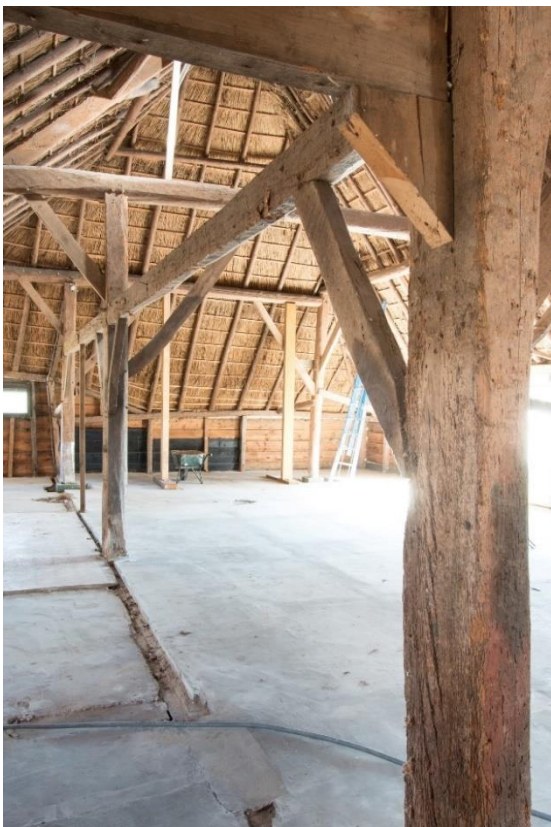
De windverbanden en regels tussen de stijlen van de verschillende gebinten zijn vlak uitgelijnd, mogelijk met het oog op een wandbetimmering (waarvan niet duidelijk is dat die er is geweest). Op de foto rechts telmerk V.
