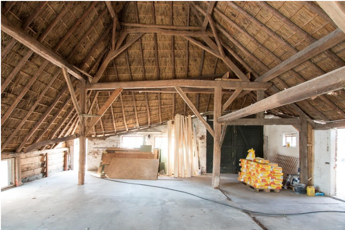
Gebint III gezien in de richting van de westgevel. Op het gebint een dekbalkspant. In de zijbeuk voor de kar een secundaire ondersteuningsconstructie.
