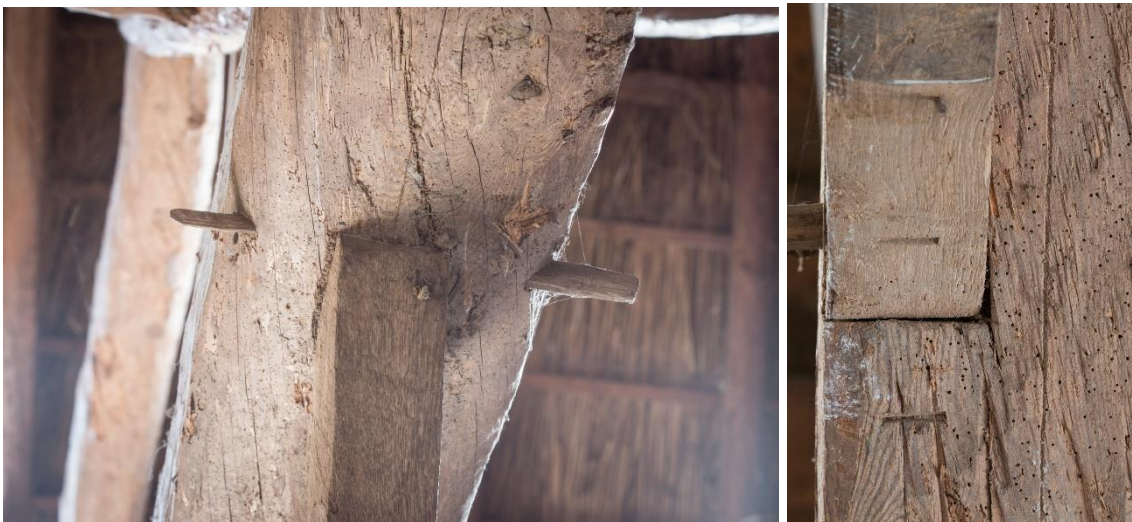
De slagrichting van de toognagels vertelt hoe de gebinten op locatie zijn neergelegd alvorens te zijn opgericht. Rechts nog een detail waarop de hart- of stellijn duidelijk is te zien (verticale aftekening).
