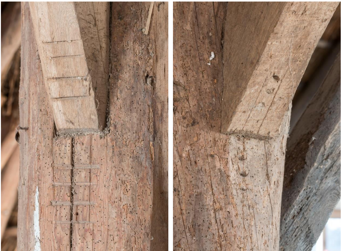
In detail gehakte merken. Links met bijtel, rechts met guts. Ook zijn kraslijnen op het hout te onderscheiden.
