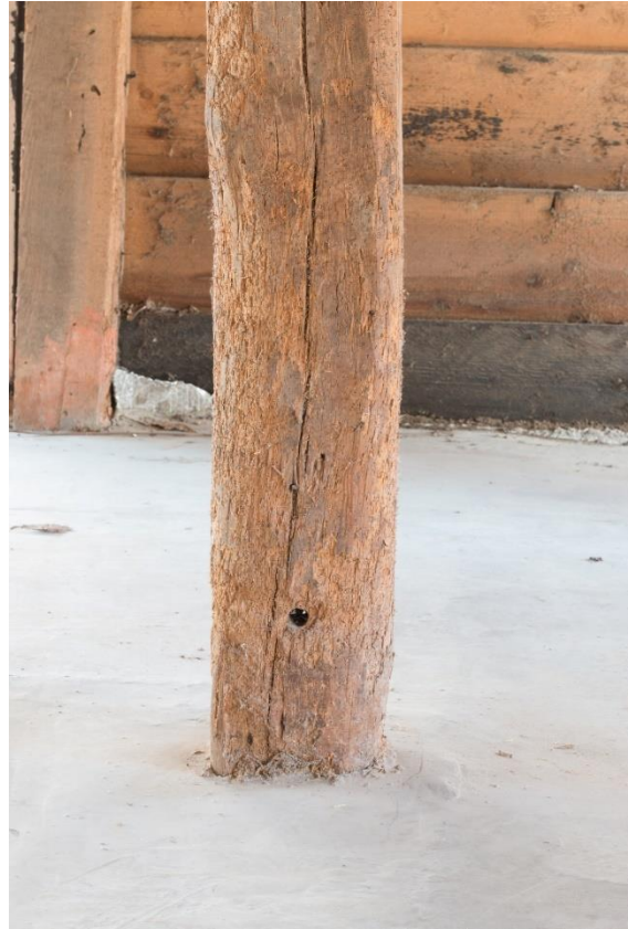
Links is nogmaals te zien hoe de regels en de windverbanden aan de zijde van de karbeuk zijn uitgelijnd. Rechts is een gat te zien, zoals in de voet van iedere stijl aanwezig, vermoedelijk om het stellen van de gebinten te vergemakkelijken.
