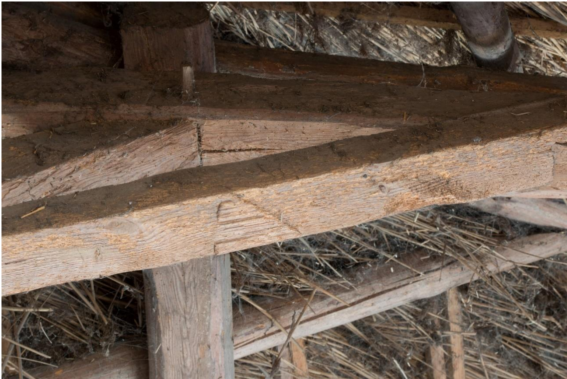
Korbeel van het dekbalkspant van gebint III met aan de onderzijde een wigvorm, ontstaan waar zaagsneden bij elkaar kwamen. Dit is een aanwijzing dat het meeste hout met de hand is gezaagd.
