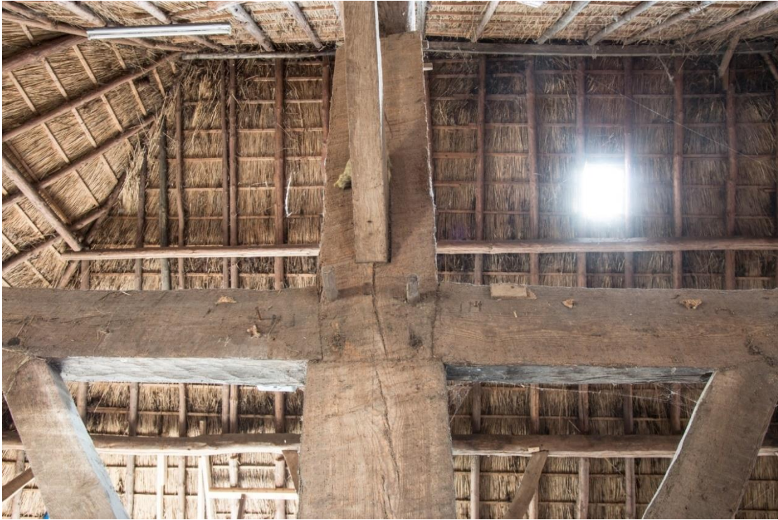
Aansluiting van de regels op de stijl van het tweede gebint. Hier met bijtel en guts gehakte merken.
