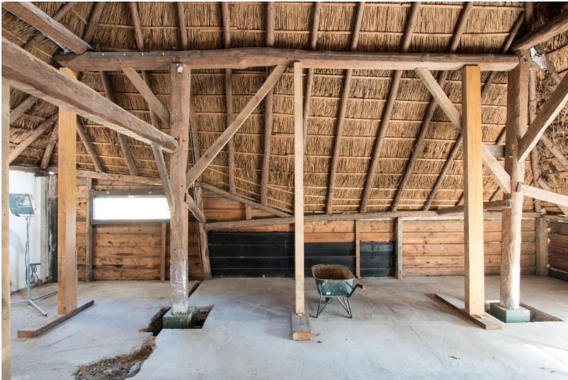
Gebint I gezien in de oostelijke richting. De muurplaat van de houten gevel is middels regels en gesmede nagels aan de gebintstijlen verbonden.
