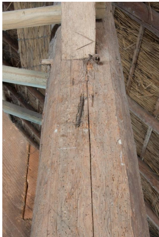
De windverbanden en regels tussen de stijlen van de verschillende gebinten zijn vlak uitgelijnd, mogelijk met het oog op een wandbetimmering (waarvan niet duidelijk is dat die er is geweest). Op de foto rechts telmerk V.
