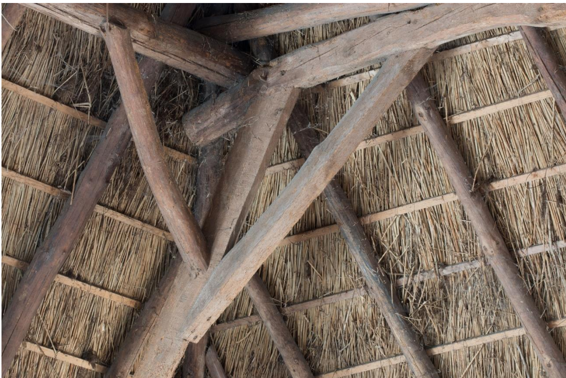
Gebint III met detail van het dekbalkspant.
