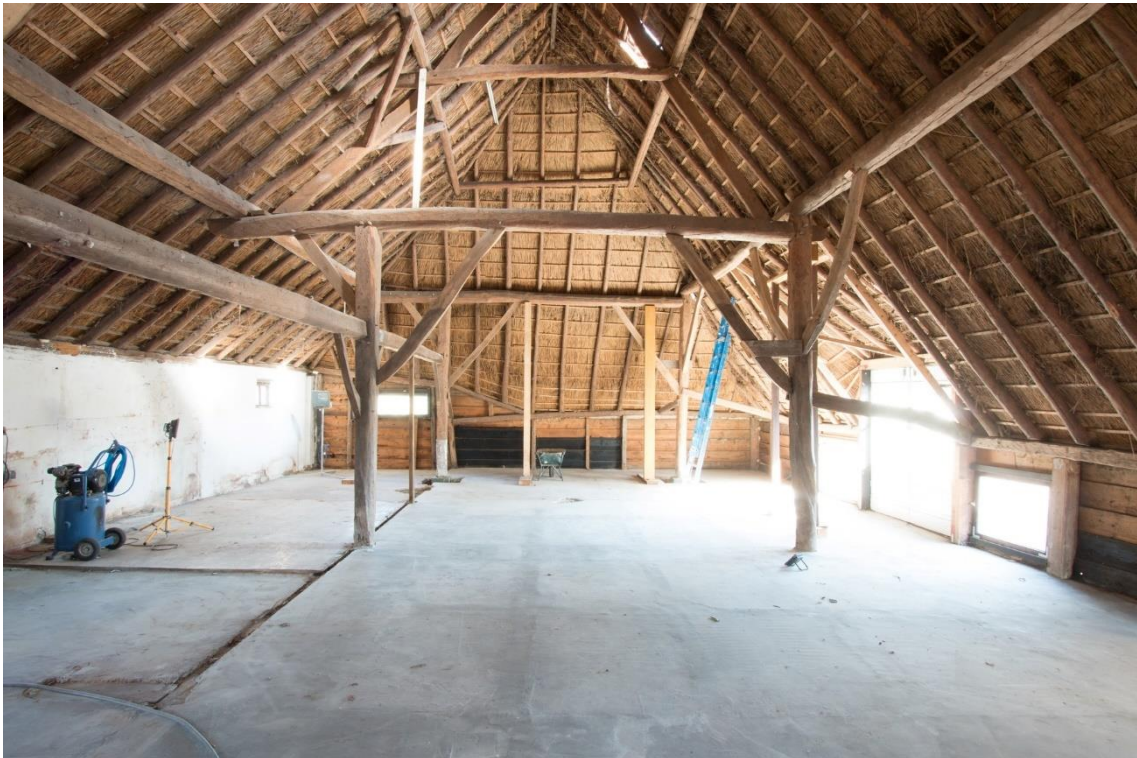
Gebint II gezien in oostelijke richting. Links de brede beuk voor de kar. Dit gebint heeft een volledig A-spant met trek balk.
