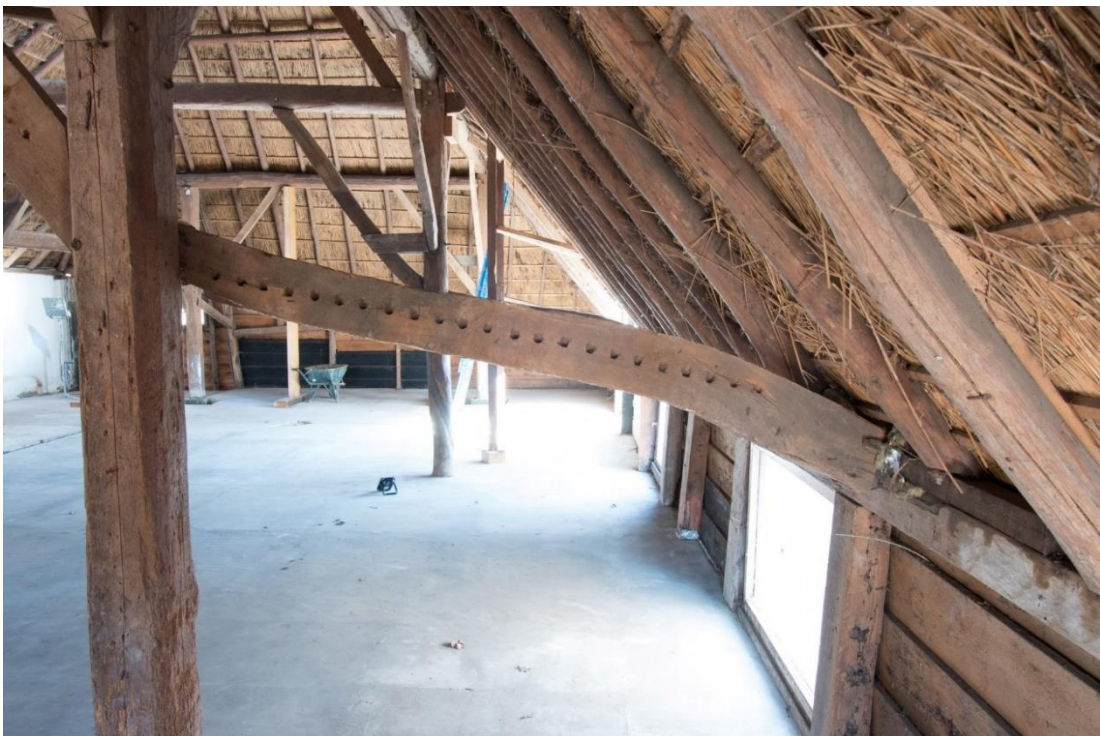
Gebint III stijl gekoppeld aan de muurplaat door middel van een hergebruikte krommer. Herkomst krommer onbekend.
