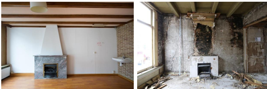
Vaak blijft bij een verkenning veel aan het ook van de bouwhistoricus verborgen. Links de situatie vóór ontmanteling, rechts na, met een achttiende-eeuwse balklaag, een negentiende-eeuwse schouw en een voormalige buitengevel (zestiende-eeuws) met daarin dichtgezette vensteropeningen. Voorbeeld: Breestraat 68 in Leiden.
