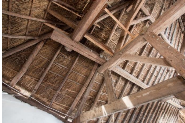
Gebint III met detail van het de secundaire hulpconstructie over het overstek dat rekening houdt met inrijden van een kar. Rechts van onderaf gezien het overstek van de gebintplaat, ten behoeve van de karinrit.
