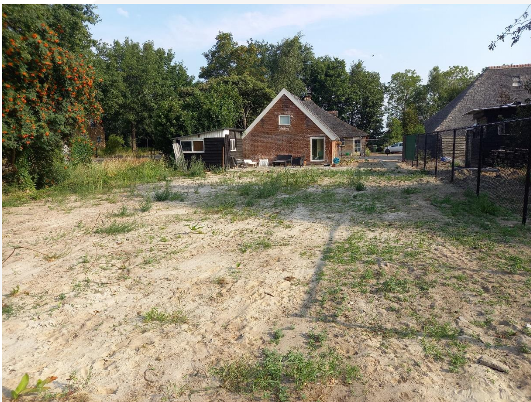
Figuur 11. Bouwvlak nieuwbouw met op de achtergrond de praktijkruimte.
