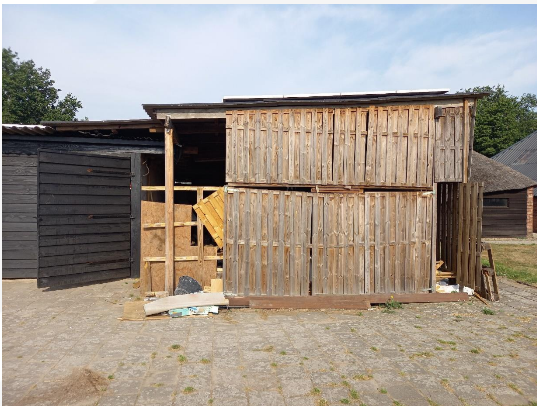
Figuur 15. Te slopen aanbouw bij de kantine.
