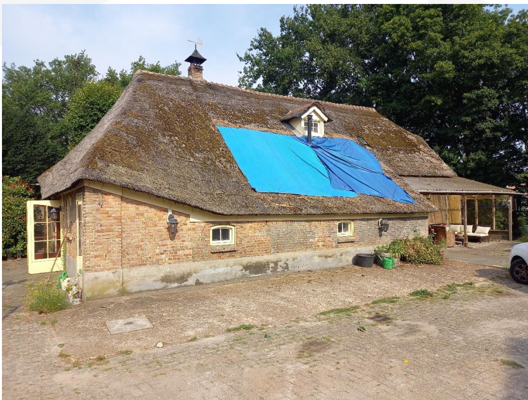
Figuur 6. Achterzijde boerderijwoning.
