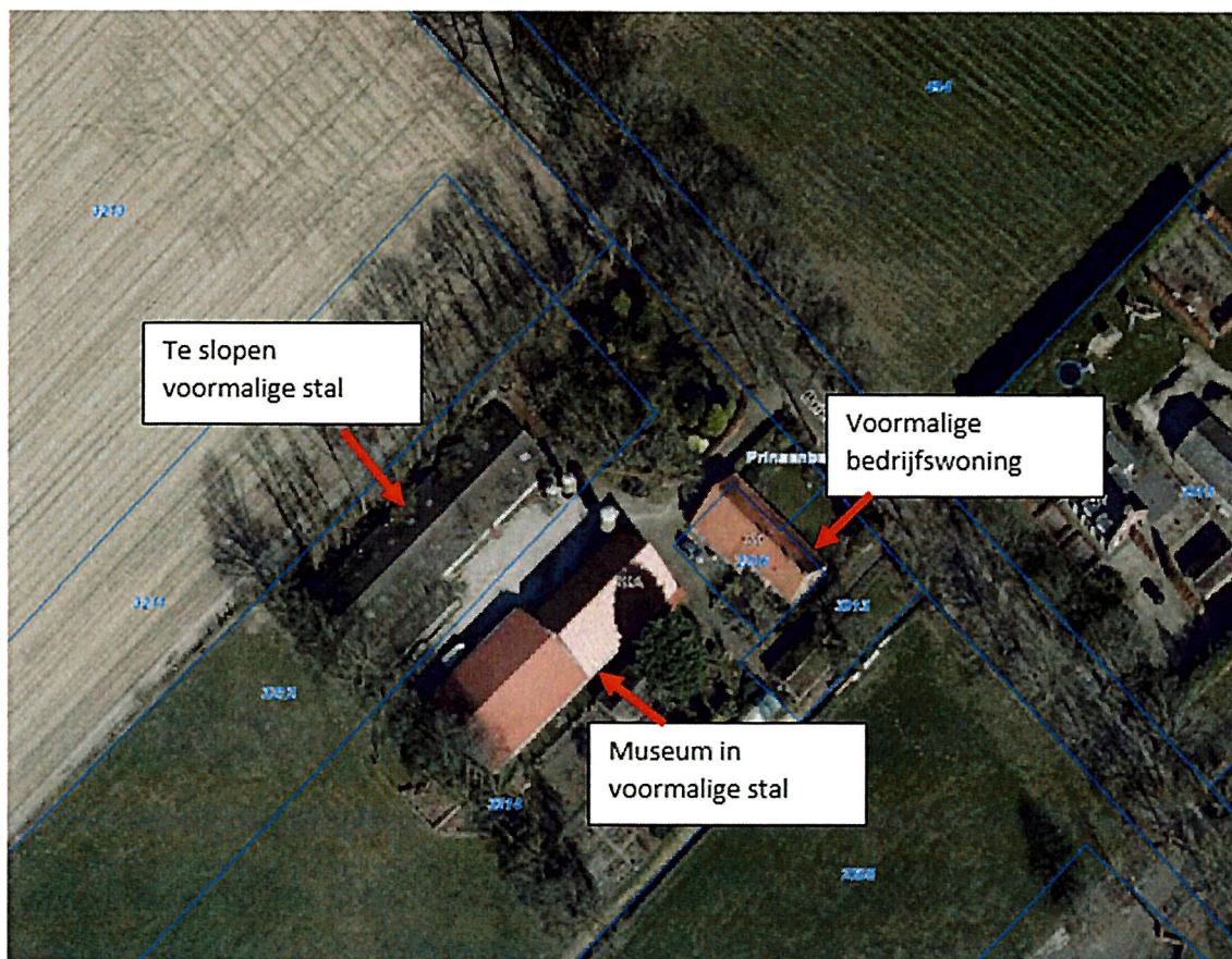
Luchtfoto bestaande situatie met de te behouden en te slopen bebouwing
