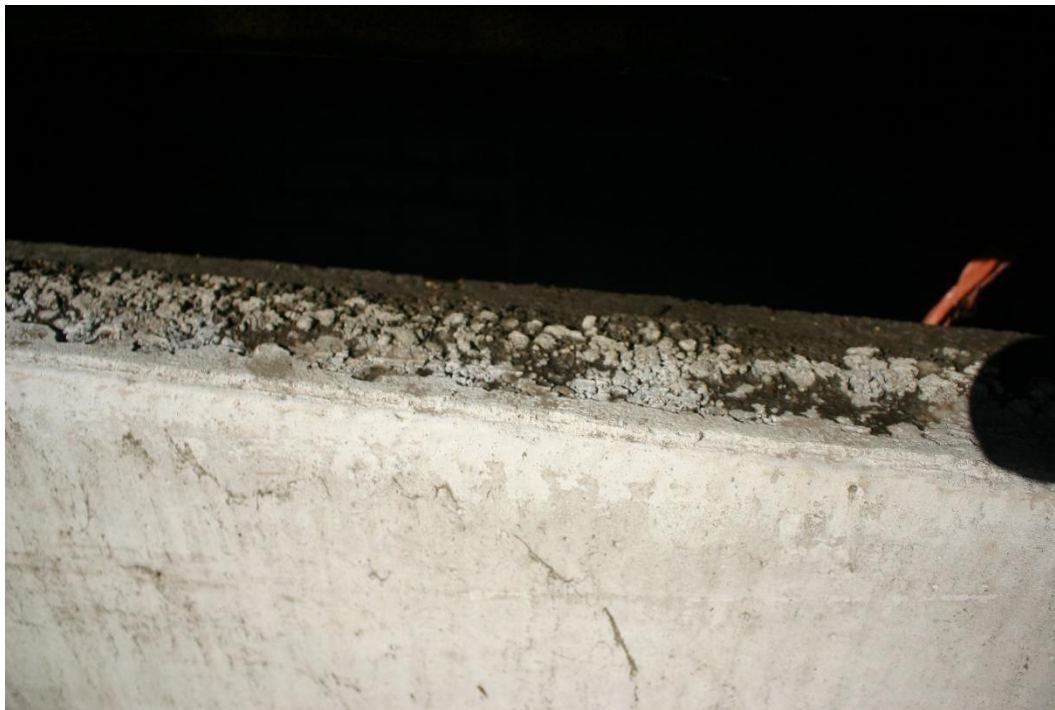
Figuur 4.4.4. De gevels van de stal zijn enkelwandig. Het voorkomen van vleermuisverblijven is hier uitgesloten.
