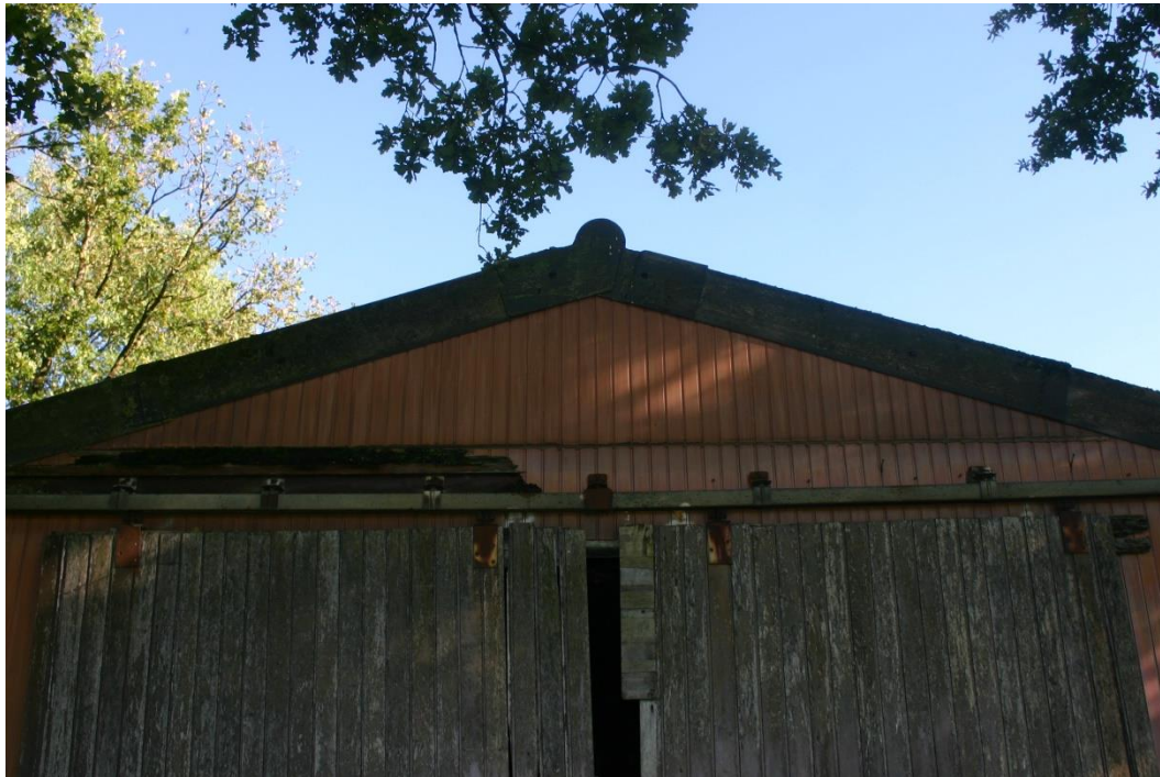
Figuur 4.4.3. Door de gladde houten gevelbetimmering kunnen vleermuizen niet onder de windveer kruipen.
