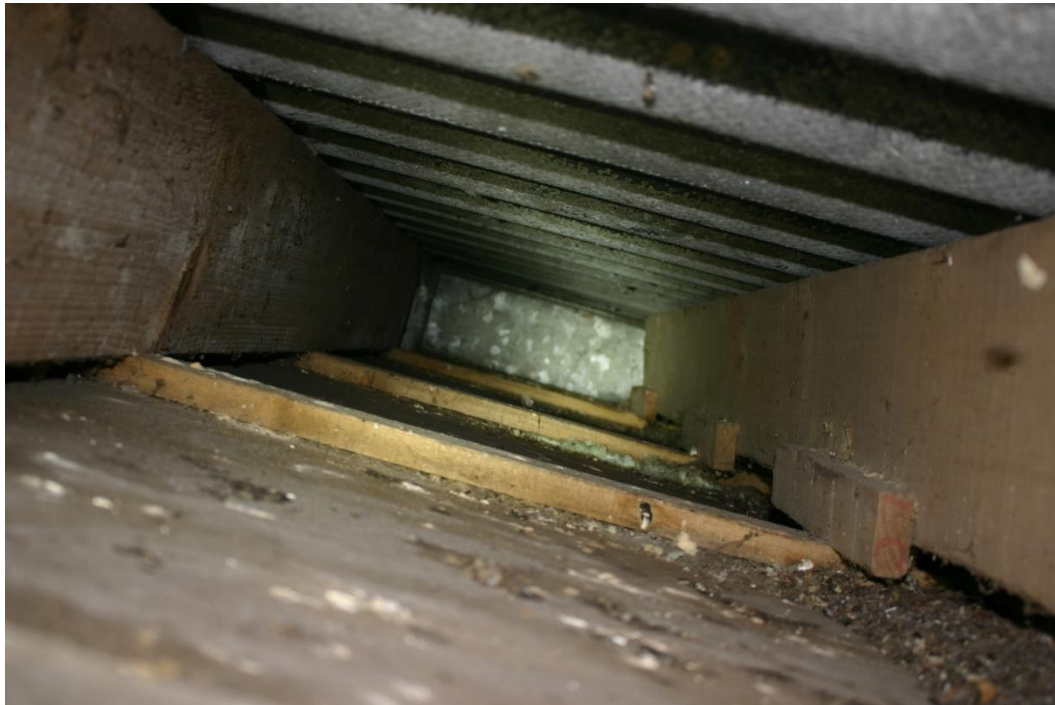
Figuur 4.4.2. De openliggende ruimtes tussen het dakbeschot en de golfplaten zijn geïnspecteerd maar vogelnesten etc. zijn afwezig.
