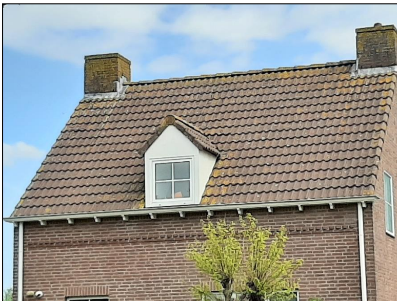
Figuur 19. Ruimtes onder dakpannen van de hoofdbebouwing van de Strijbeekseweg 15.
