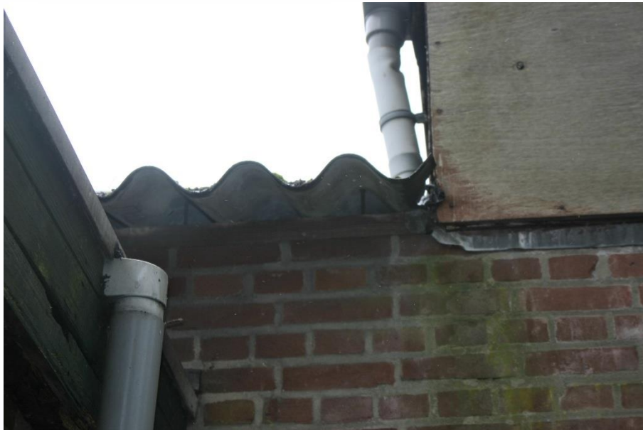
Figuur 4.4.3. Door het ontbreken van vogelschroot is het dak toegankelijk voor vogels, maar ook voor steenmarter.
