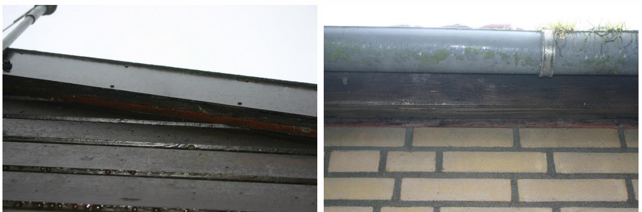
Figuur 4.4.2. Voor vleermuizen is de ruimte tussen de windveer en de kopgevels te tochtig en tussen de lange gevels en het dakoverstek zijn geen kieren en spleten aanwezig.
