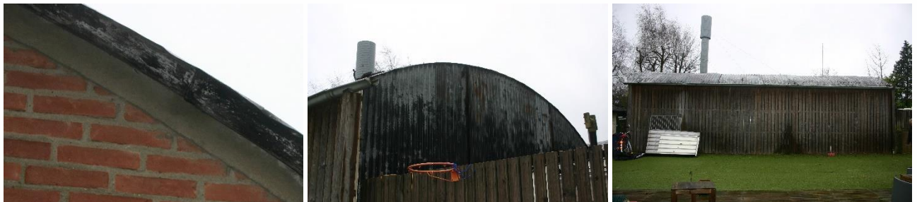
Figuur 4.4.1. De voorgevel van de loods is afgestreken met specie, de achtergevel bevat gladde golfstalen platen en de zijgevel bevat een houten framework met daarachter een glaswand. Vleermuizen kunnen daardoor nergens de spouw niet bereiken.
