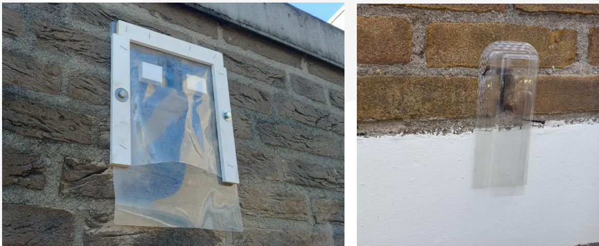
Figuur 2. Voorbeelden van twee soorten exclusion-flaps, waarmee vleermuizen uit een gebouw verdreven kunnen worden.
