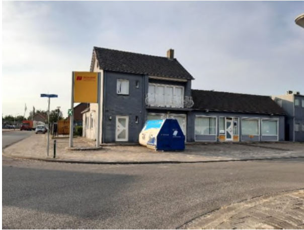
Fotonummer: 1 Omschrijving: Wieringenstraat 75
