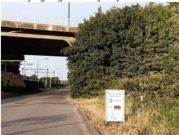
Fotonummer: 17 Omschrijving: Hoge Schouw/spoorlijn
