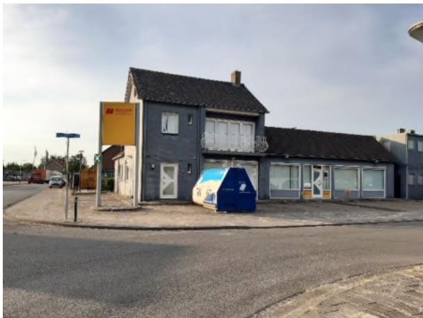
Fotonummer: 1 Omschrijving: Wieringenstraat 75
