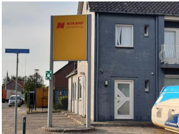
Fotonummer: 2 Omschrijving: Wieringenstraat 75
