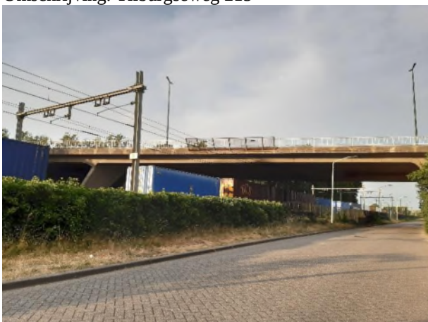
Fotonummer: 15 Omschrijving: Hoge Schouw/spoorlijn
