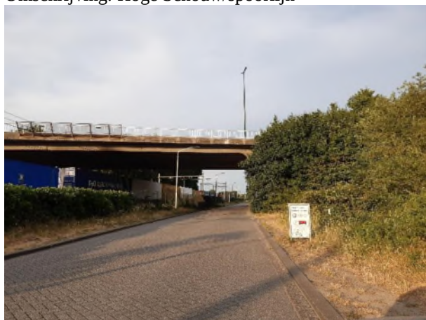
Fotonummer: 16 Omschrijving: Hoge Schouw/spoorlijn
