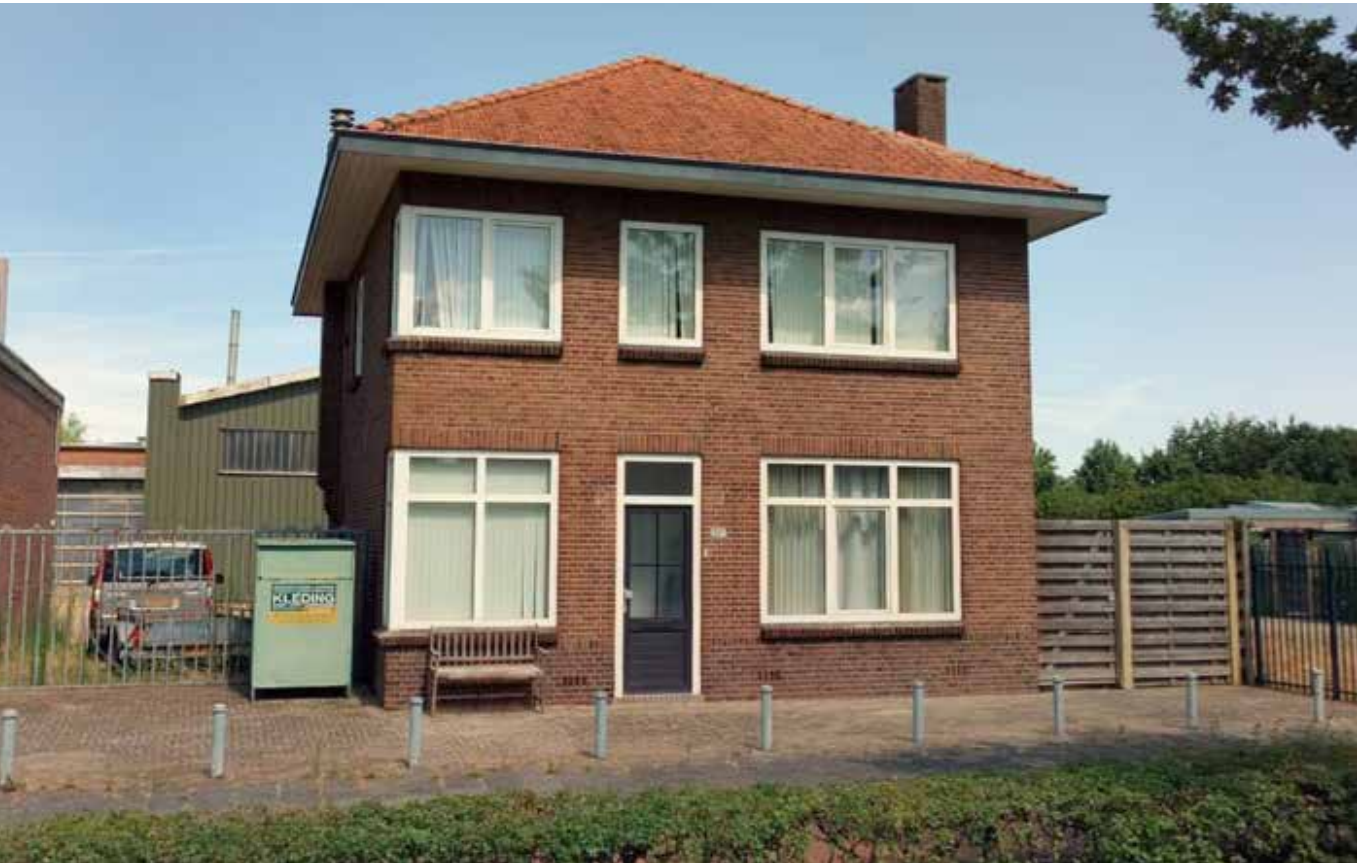
Bestaande/te handhaven jaren-'30 woning aan de Tilburgseweg 217.
