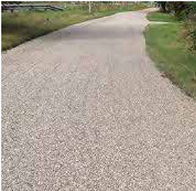
Asfaltpad: voorbeelden van een asfaltpad met een fijne en/of gele afstrooilaag.
