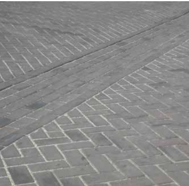
Verharding: Voorbeelden van verschillende materialen en de toepassing streklagen en vlakken in afwijkend materiaal.
