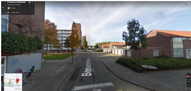
Afb. 2.1 Oude situatie met de 4 inmiddels gesloopte flats
