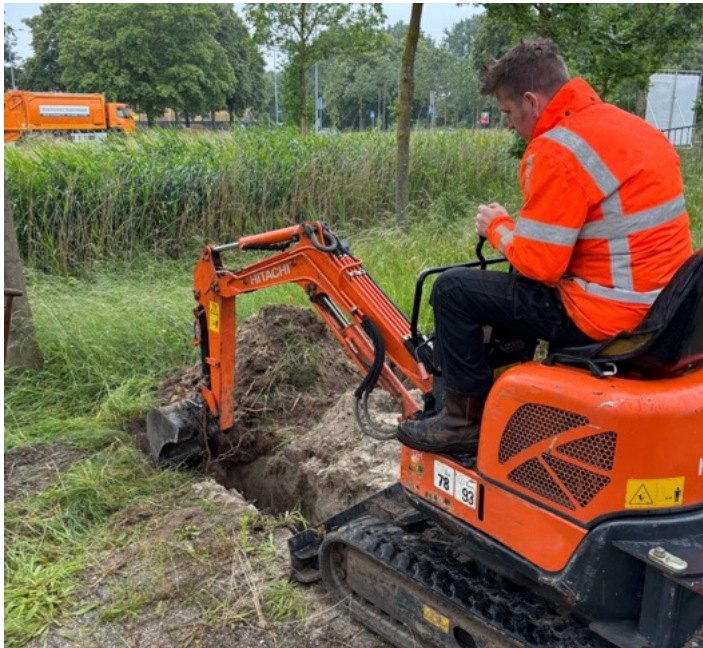
Afbeelding 10 en 11) Onder de bestrating zijn geen wortels aangetroffen. Kabel in mantel zoals aangegeven op de Klic. Profiel kuil #1.
