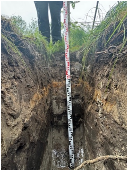
Afbeelding 12) Proefkuil #2 met een zandlaag en zeer veel puin.
