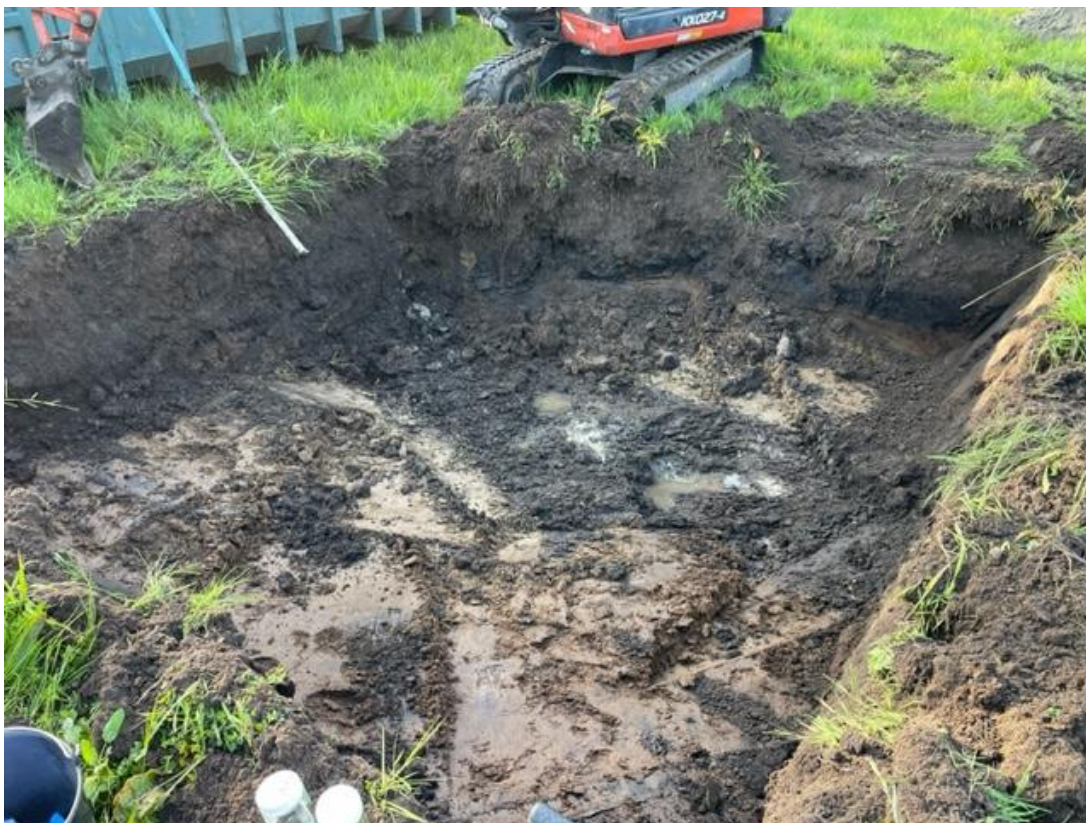
Ontgraving nabij boring 7
