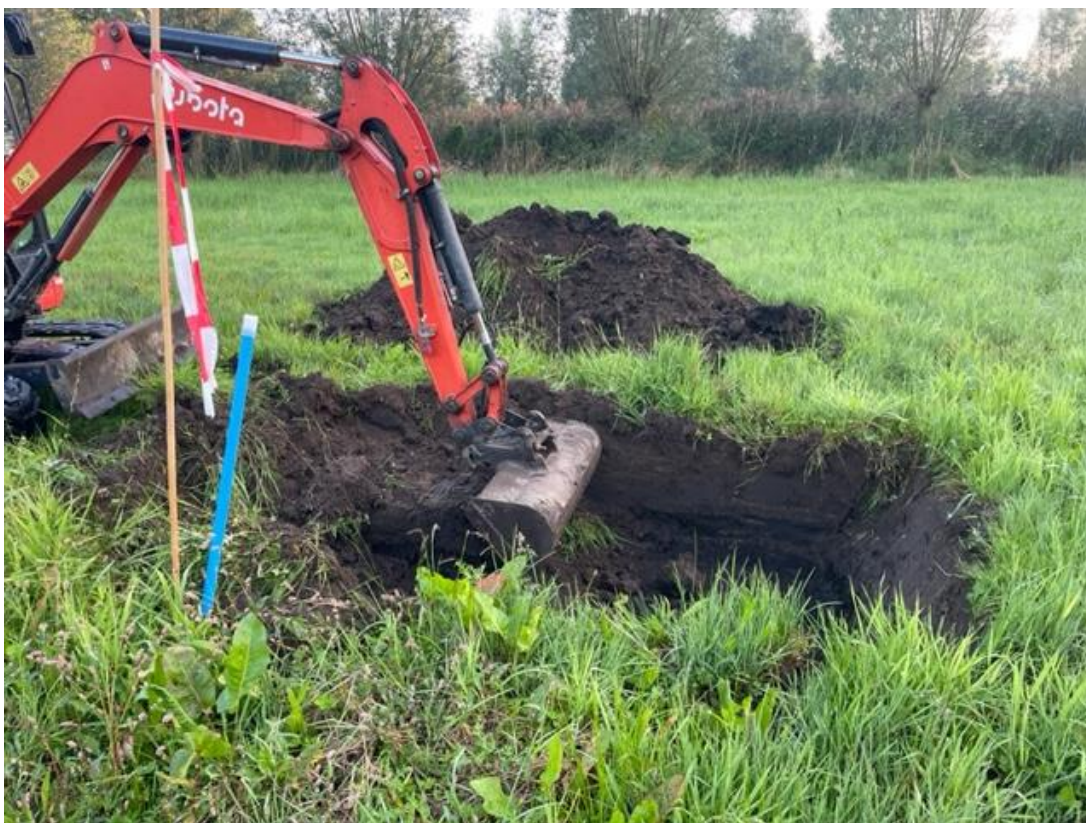
Ontgraving nabij boring 7
