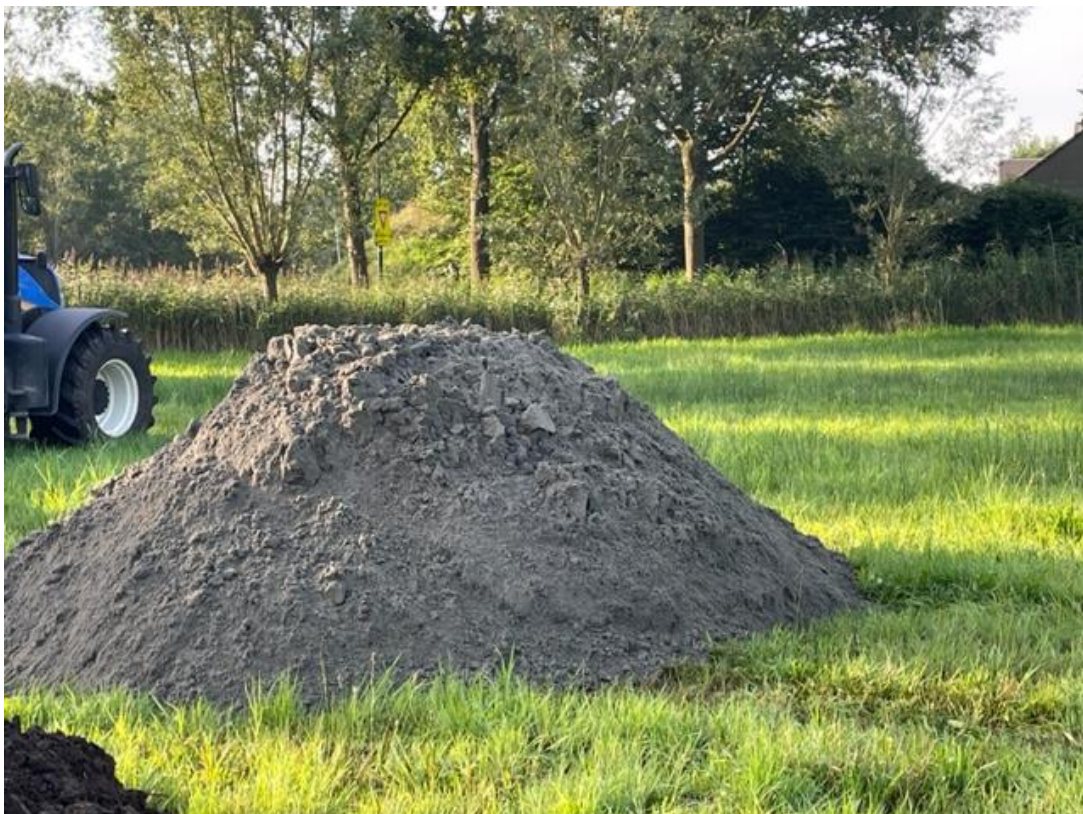
Aanvulgrond voor ontgravingsput nabij boring 7
