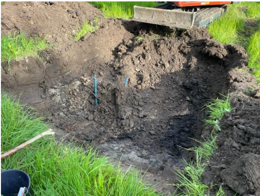
Ontgraving nabij boring 1
