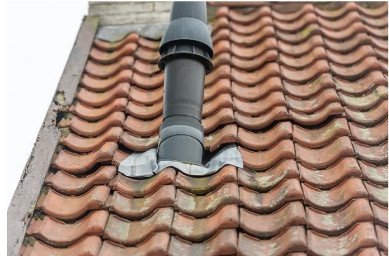
openstaande dakpannen geven toegang voor vleermuizen, huismus en gierzwaluw om een verblijf te vestigen.
