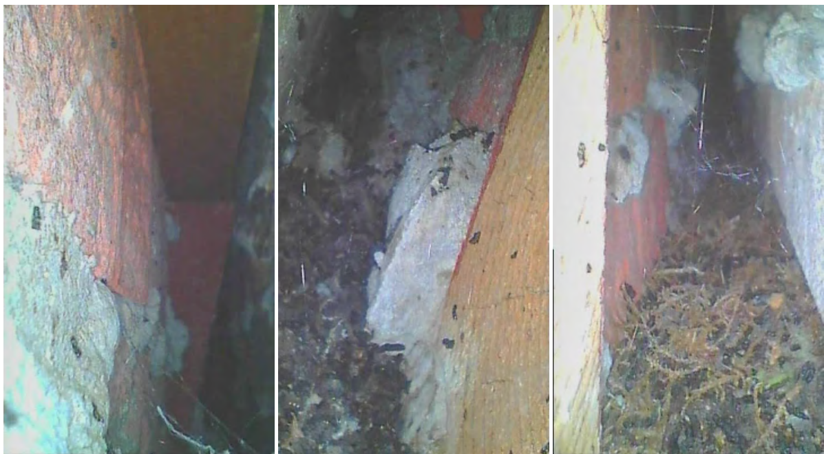
Afbeelding 4: Overzicht van spouwmuur inspecties
