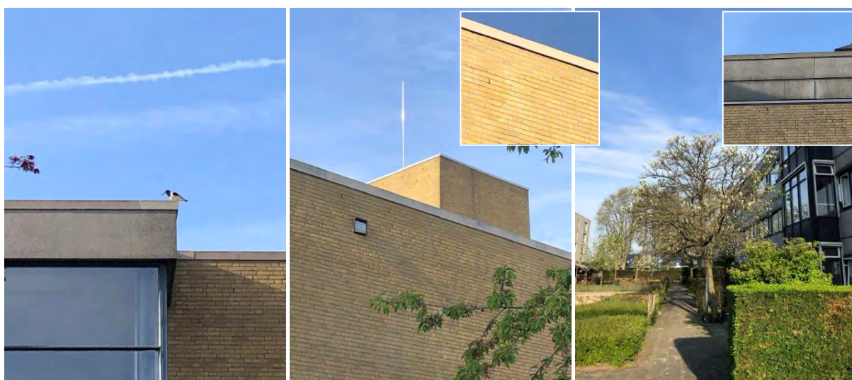
Afbeelding 4: Impressie plangebied en detail stootvoegen en houten bekisten.
