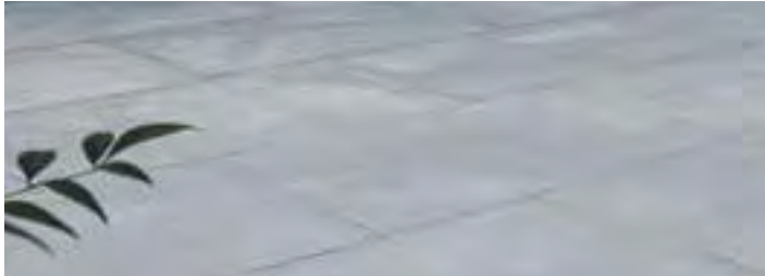
Referentie : Betontegels 40x60 cm op terrassen
