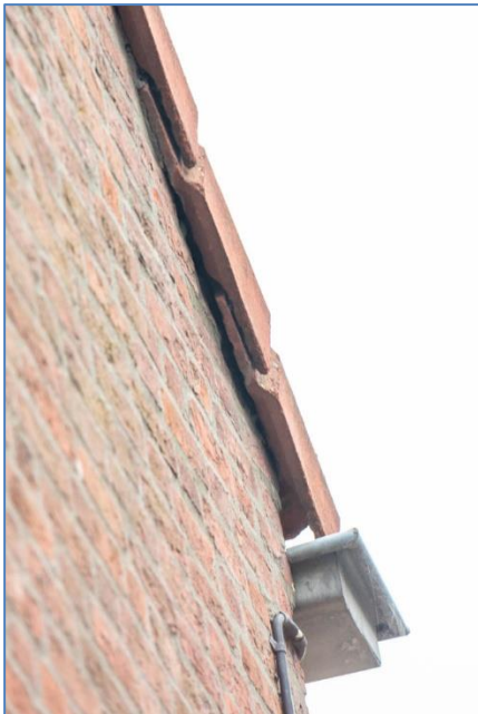
Figuur 08: Kantpannen met toegang tot ruimte erachter.
