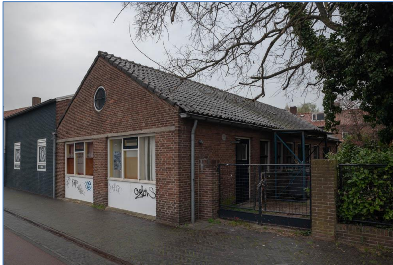
Figuur 13: pand met pannen.
