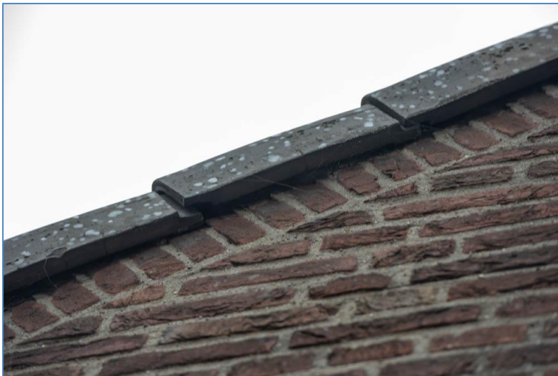
Figuur 13: kantpannen met toegang tot ruimte erachter.
