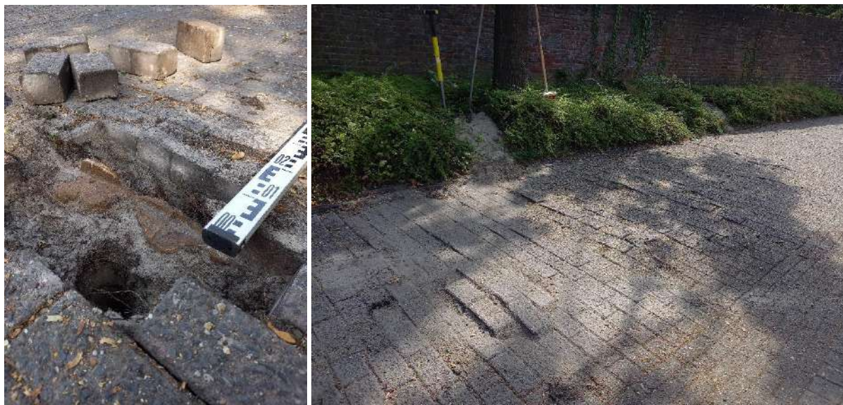
Afbeelding 6: Weergave opdruk rondom boom 3 (rechts) met de aangetroffen stabiliteitswortels tussen en onder de klinkers;
