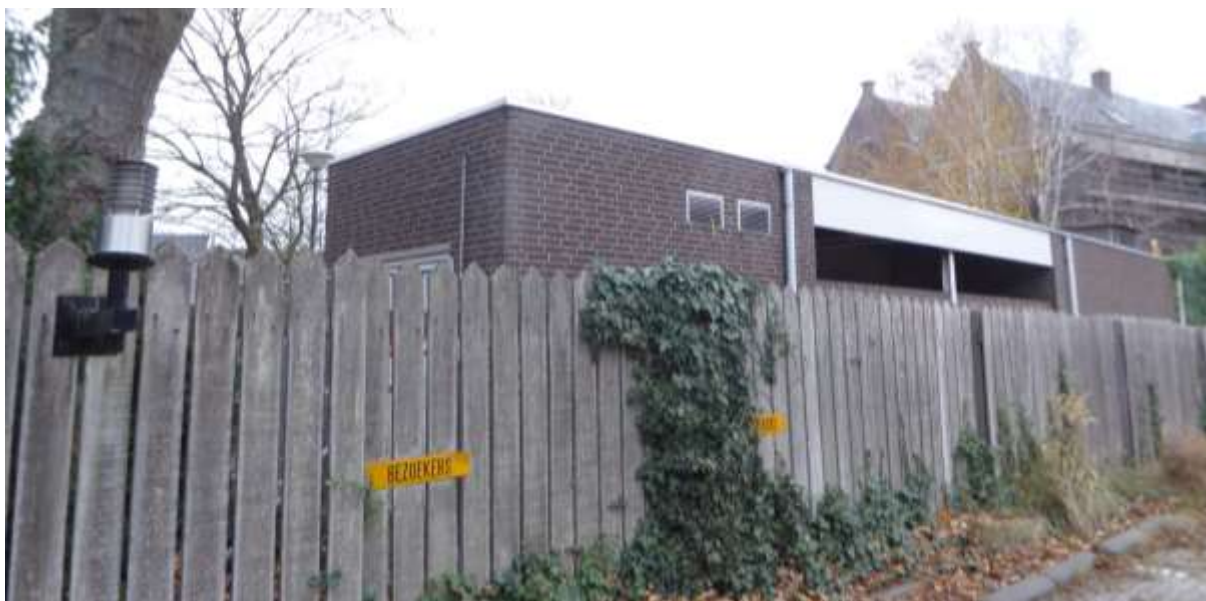
Figuur 2. Het transformatorhuisje in het noordelijke deel van het plangebied (situatie 21 november 2018) heeft een plat dak. Het is een gebouw dat via een nauwkeurige inspectie volledig te onderzoeken is op aanwezigheid van vleermuizen.
