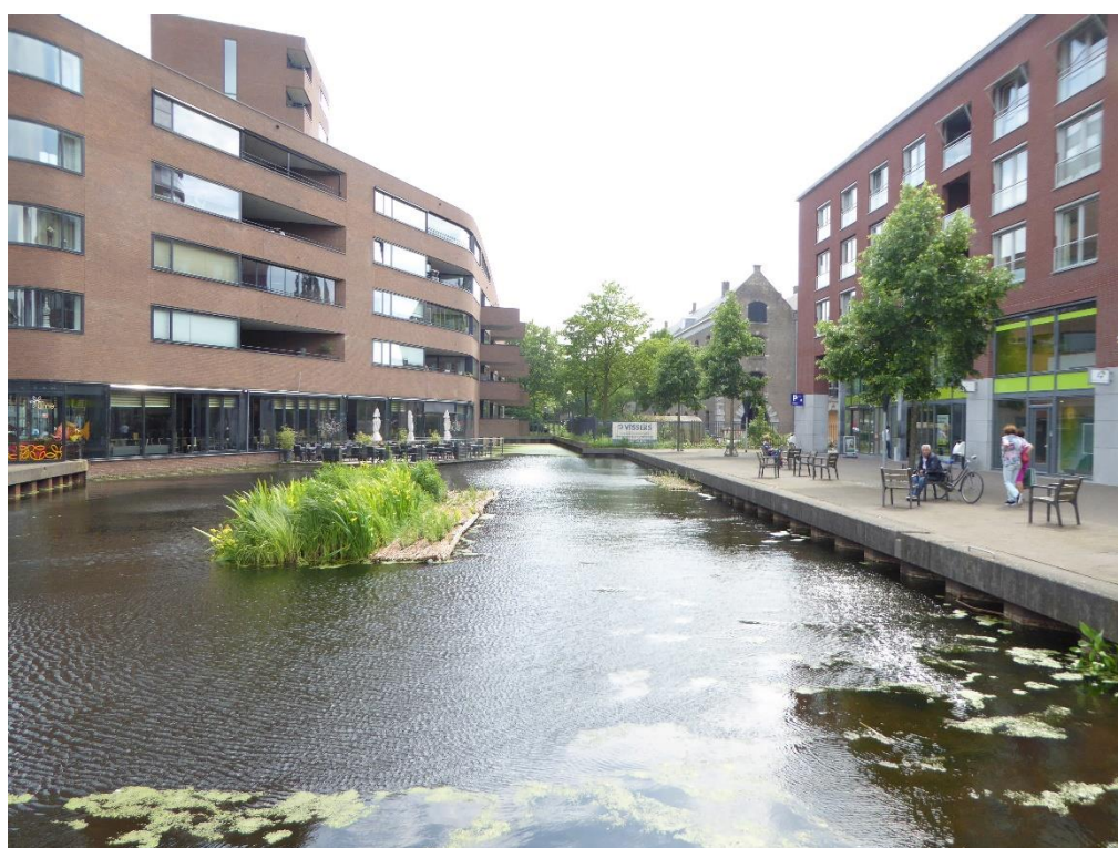
Figuur 13. Deelgebied 2. Volgens plan zal de Nieuwe Mark hier in zuidelijke richting op aansluiten.
