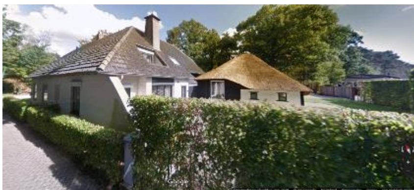
Figuur 2.2 Huidige situatie vanaf de zuidoostzijde (bron: Google Maps)
