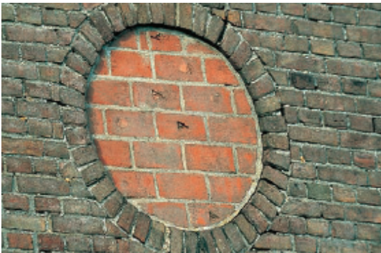
Figuur 20: dichtgemetselde toegang (bron: Vogelbescherming Nederland)
