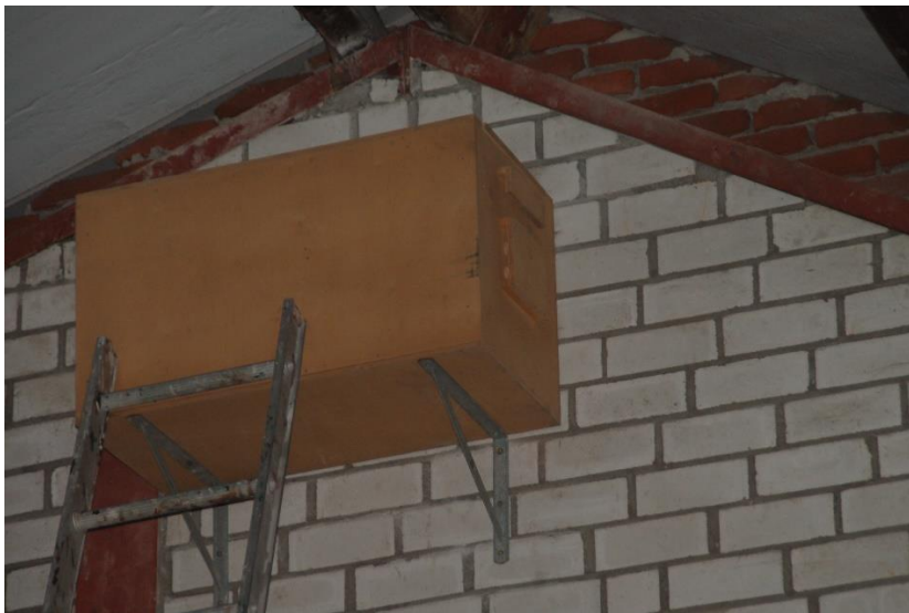
Kerkuilen kast binnenzijde loods
