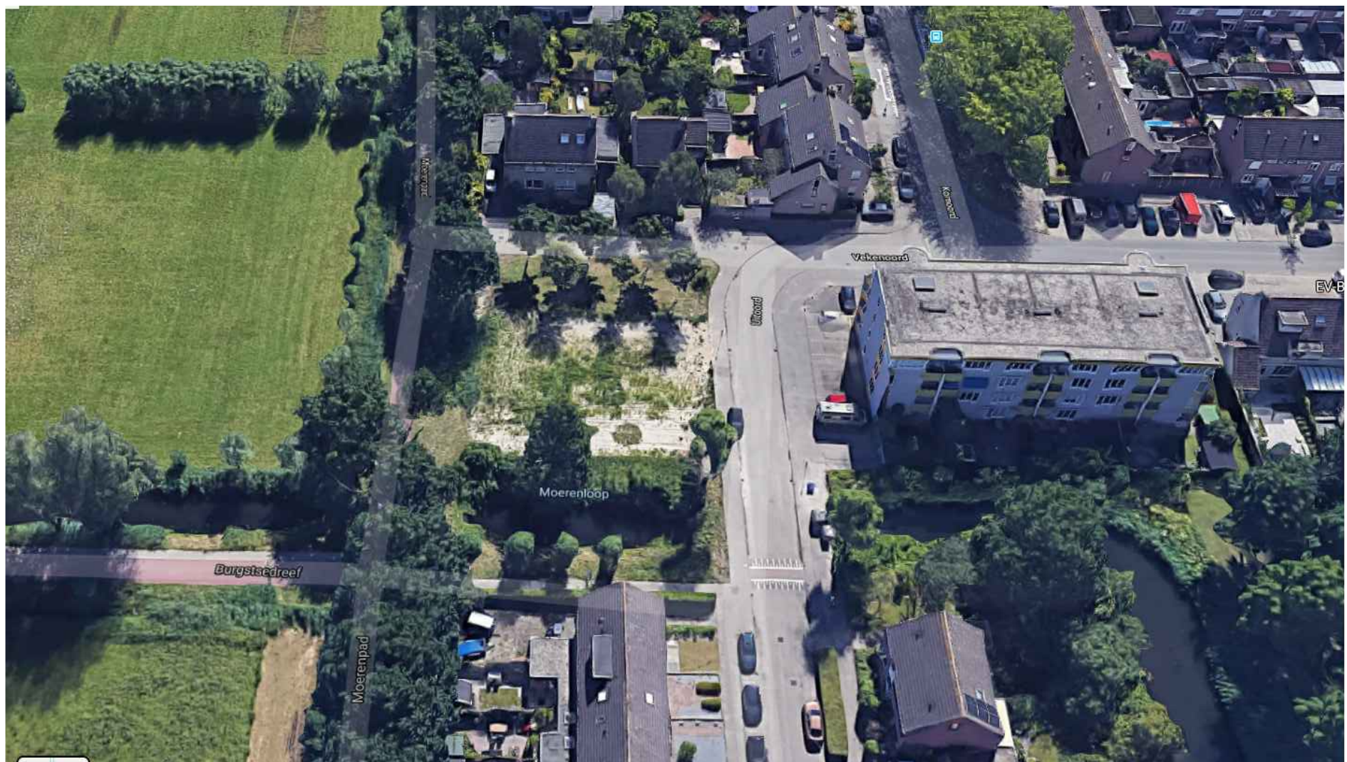
Foto vanuit het Westen
