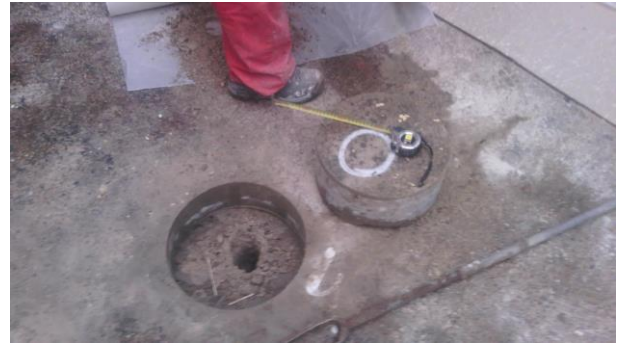
Asbestgat 350 mm
