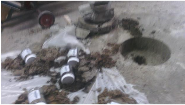
Asbestgat 350 mm
