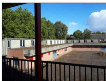
Figuur 3. Binnenplein met (voormalige) stallen.
