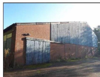
Figuur 5. Achtergevel binnen-paardrijbak.
