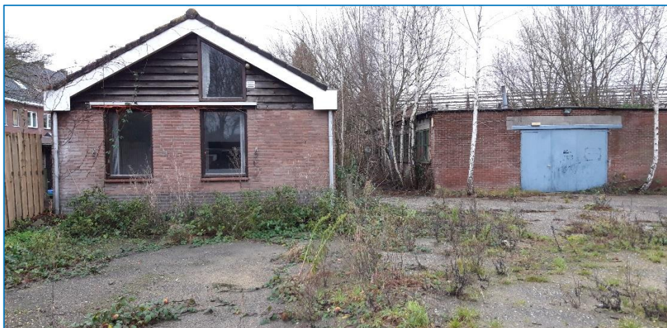
foto 19. Gebouw A (links) en gebouw B (rechts). (in noordelijke richting).
