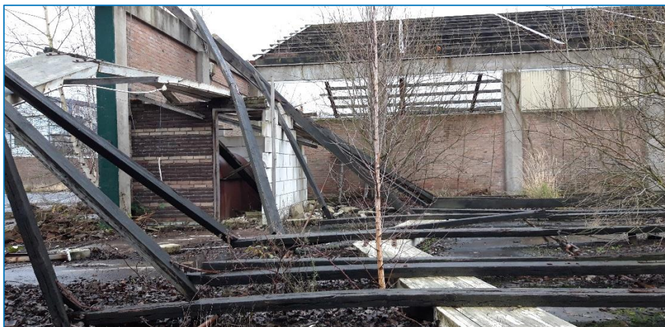
foto 7. Loods 4 met bovengrondse tank (in zuidoostelijke richting).
