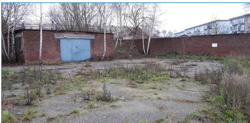
foto 20. Gebouw B (rechts). (in noordoostelijke richting).
