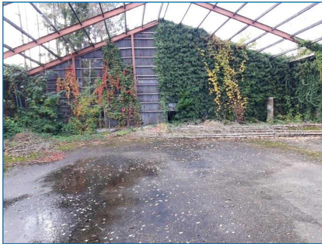
foto 1: Loods 3 (westelijke richting)
