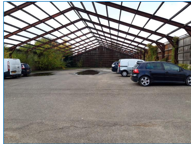
foto 12: Loods 5 (westelijke richting)
