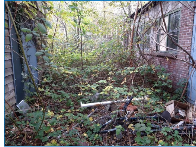
foto 14: Zuidelijke deel (west) onderzoekslocatie t.p.v. Lachappellestraat (noordwestelijke richting)
