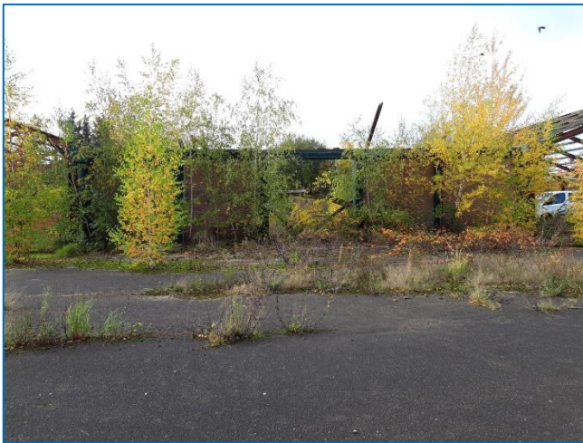
foto 7: Loods 4 aanzicht (westelijke richting)
