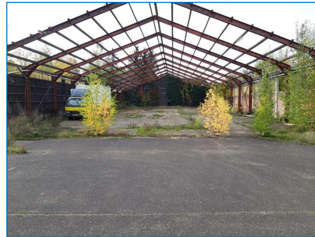
foto 8: Loods 3 aanzicht (westelijke richting)
