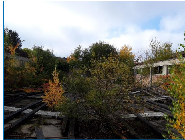
foto 10: Loods 4 (westelijke richting)
