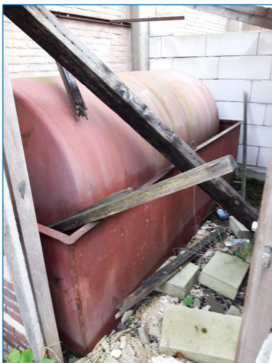
Figuur 9: Nog aanwezige bovengrondse tank bij loods 4
