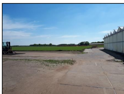
Figuur 3. Kassencomplex (rechts) gelegen op de onderzoekslocatie.
